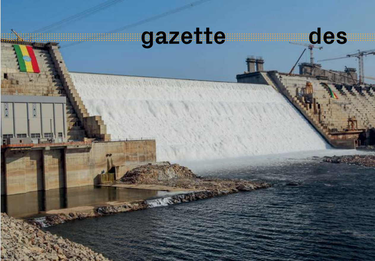
← La première des 13 turbines du Grand barrage de la Renaissance, en Éthiopie, a été mise en service le 20 février 2022. Une partie de l'électricité excédentaire produite pourrait servir à miner des bitcoins.
