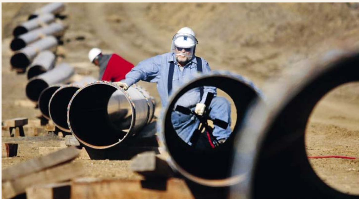
Bau einer Pipeline für den Gastransport in der Nähe der Stadt Mustang in Texas. Die Förderung von Schiefergas boomt seit sechs Jahren in der Region.
