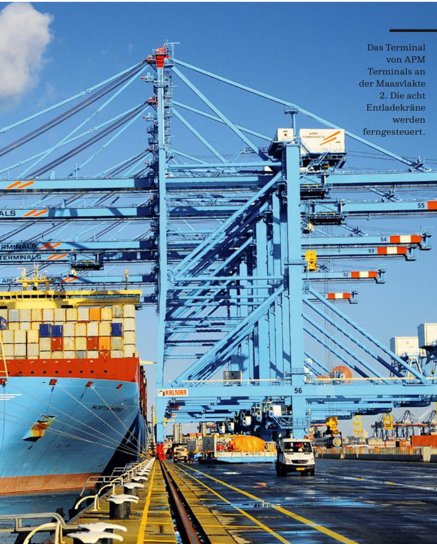
Das Terminal von APM Terminals an der Maasvlakte 2. Die acht Entladekräne werden ferngesteuert.
