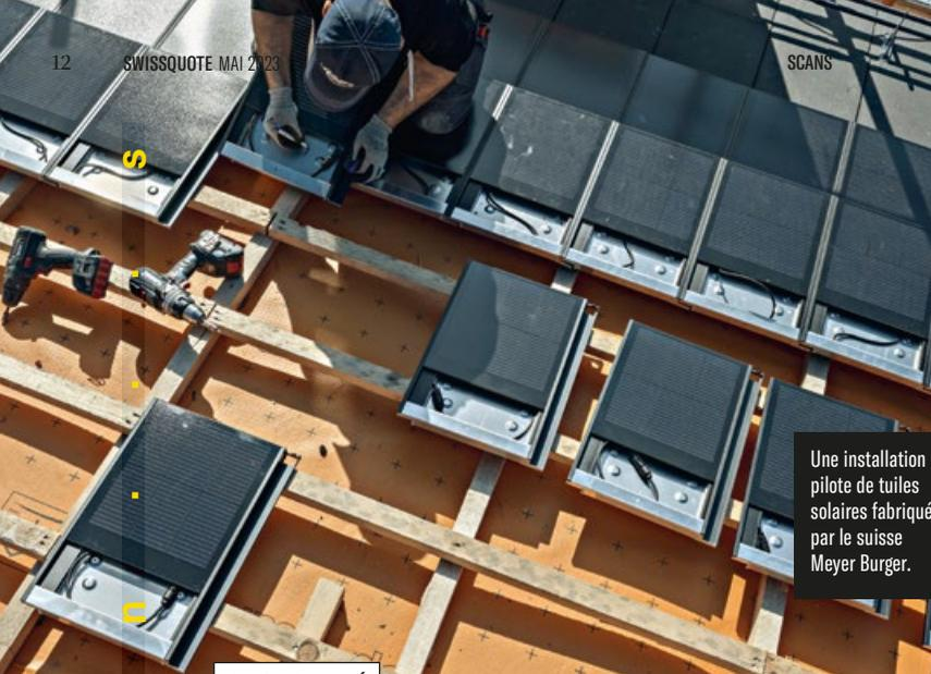
Une installation pilote de tuiles solaires fabriquées par le suisse Meyer Burger.
