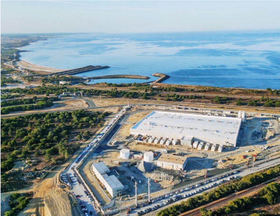
Une vue aérienne du chantier de Start Campus, un gigantesque centre de données à Sines, au Portugal. Une fois terminé, il comprendra six bâtiments pour une capacité totale de 1,2 GW, alimenté à 100% par de l'énergie verte.
